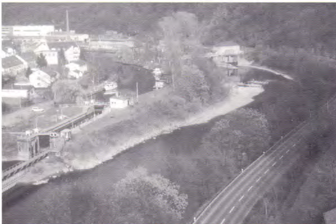
Abb. 1: Übersicht über die Wehranlage Lahnstein vom Unterwasser aus gesehen, links im Bild die Schiffsschleuse, rechts das Kraftwerk
