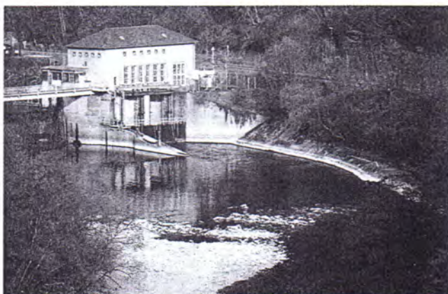
Bild 1 Unterwasser des Wehres Lahnstein bei niedrigem Unterwasserstand und geringem Abfluss der Lahn, also günstigen Befischungsbedingungen.
